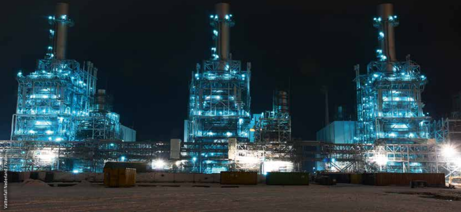
Vattenfall's Wasserstoff-Aushängeschild: Das GuD-Kraftwerk Nuon Magnum in den Niederlanden kann mit verschiedenen Brennstoffen betrieben werden, darunter Erdgas und Flüssiggas. Der 2009 veröffentlichte Plan eine „umweltfreundliche“ Kohlevergasung zu realisieren, wurde inzwischen verworfen. Stattdessen soll ab 2023 mittels Dampfreformation aus norwegischem Erdgas gewonnener Wasserstoff zum Einsatz kommen.
