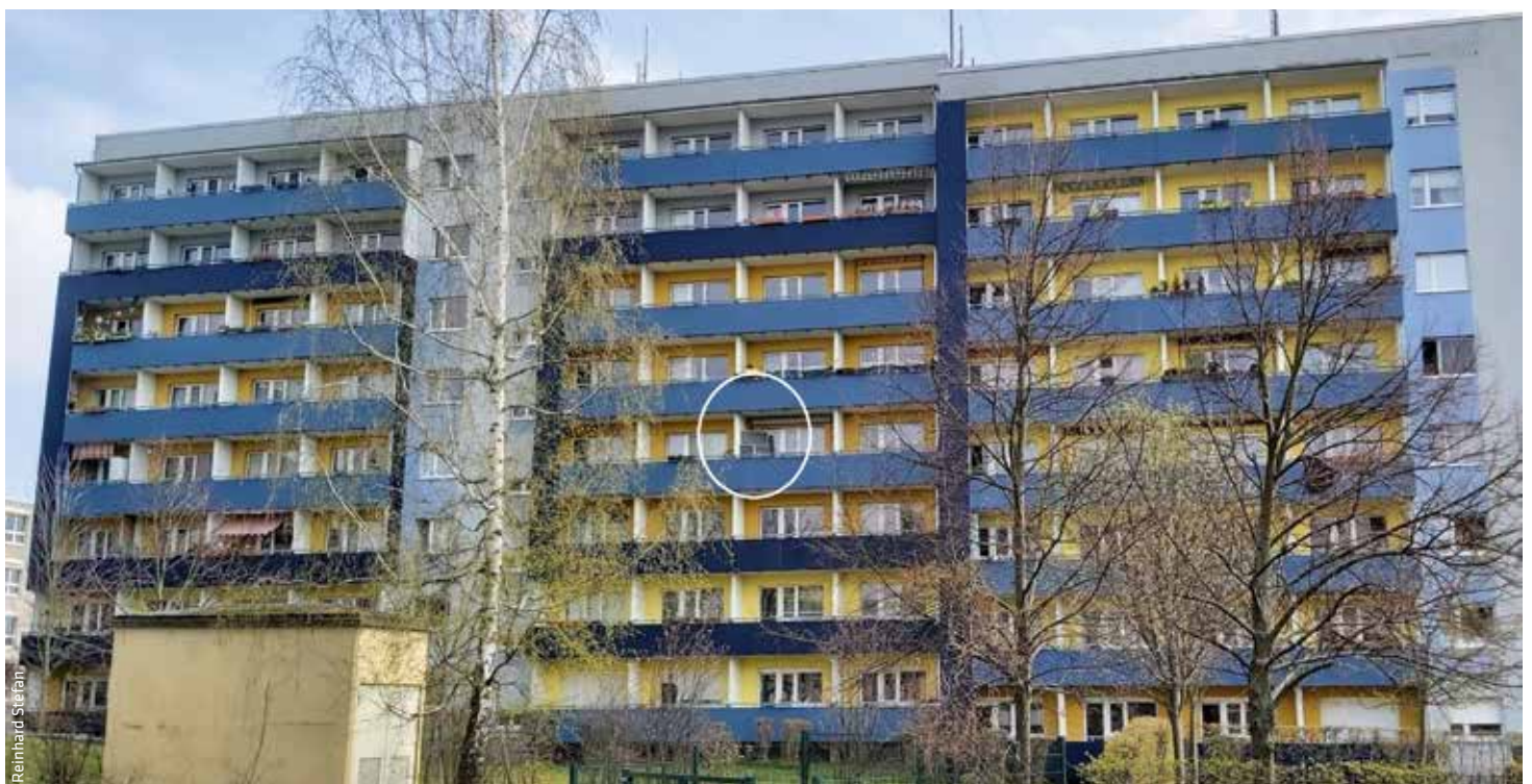
Fehlersuchbild: Entdecken Sie die optisch störende und „illegale“ PV-Anlage unseres Mitglieds?
